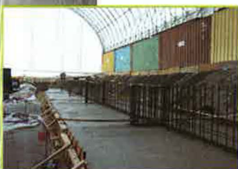
Dans le Grand Nord, le Groupe LFL se spécialise dans les travaux de génie civil, la construction et l'entretien de bâtiments, et la réalisation d'infrastructures minières et hydroélectriques dans les communautés autochtones.
